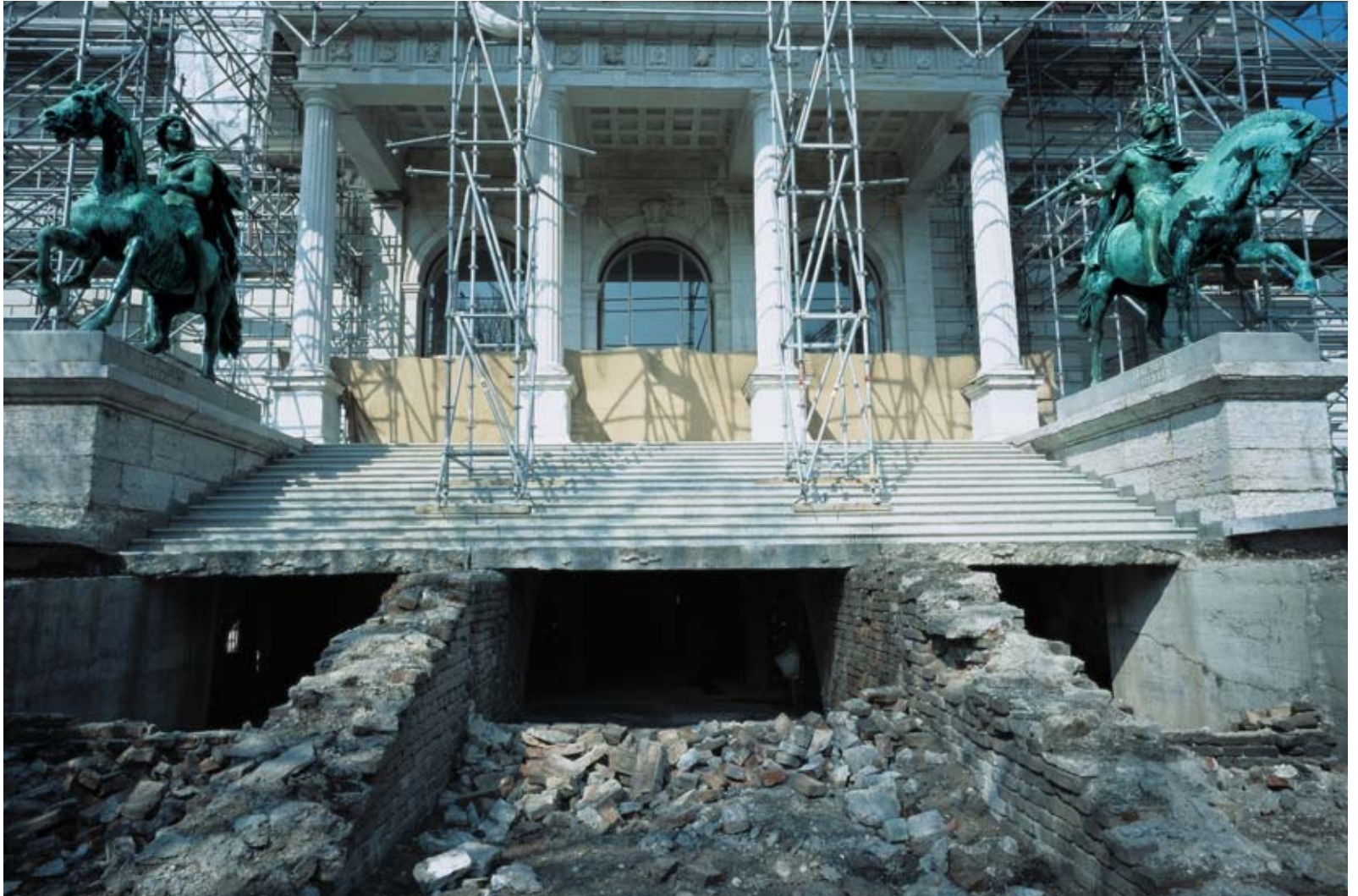
Sanierung der Freitreppe
