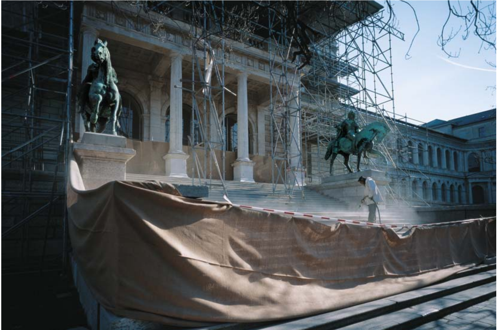
Sanierung der Freitreppe
