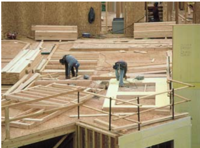
Abb. 1: Die klassische Plattformbauweise im Montagezustand – Baustelle eines 7-geschossigen Gebäudes in Seattle (USA) Foto: Winter
