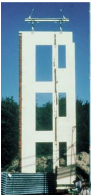
Abb. 2: Balloon – Über drei Geschosse durchgehendes Bauteil aus Merk-Dickholz.
