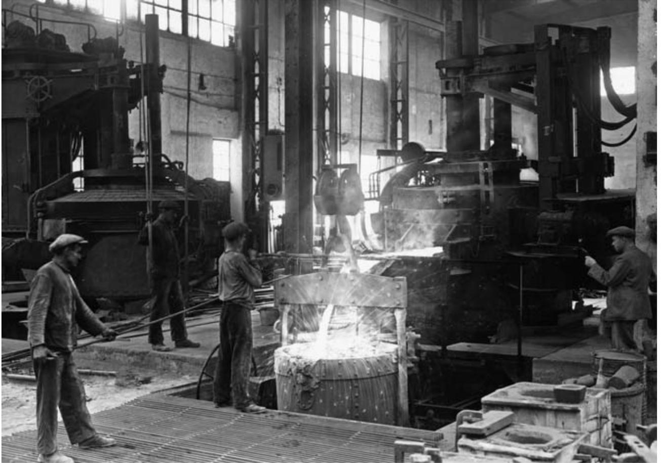
Abstich an einem Schmelzofen der Traktorenfabrik
